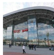
Железнодорожный вокзал в Адлере Объект введен в эксплуатацию
