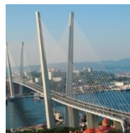
Мостовой переход через бухту Золотой Рог во Владивостоке Объект введен в эксплуатацию
