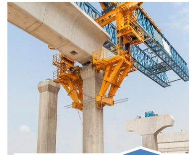
Строительство коммуникаций: дорог, мостов, сетей и пр.
